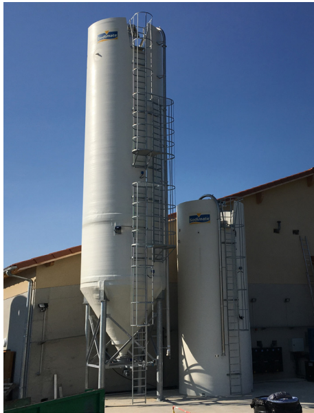
Silo con estructura y silo con faldón autoportante
