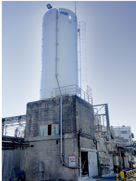
Silo sobre obra civil
