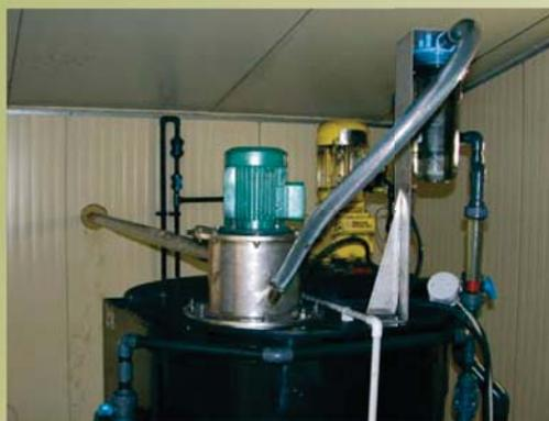
Le Sodimix fixé sur la cuve de préparation, avec l'arrivée de la vis de dosage horizontale en provenance du silo et, au-dessus de la tête du mélangeur, le flexible d'aspiration des poussières vers le filtre à eau.
