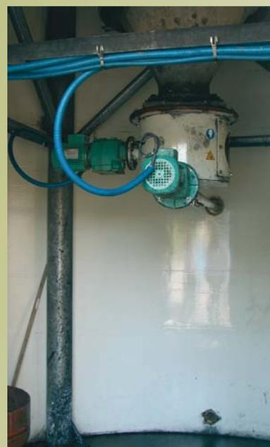
L'extraction en bas du silo, avec le moteur de la vis doseuse horizontale qui entraîne le charbon actif dans le local voisin et celui du dévouteur. On remarque la propreté du local.
