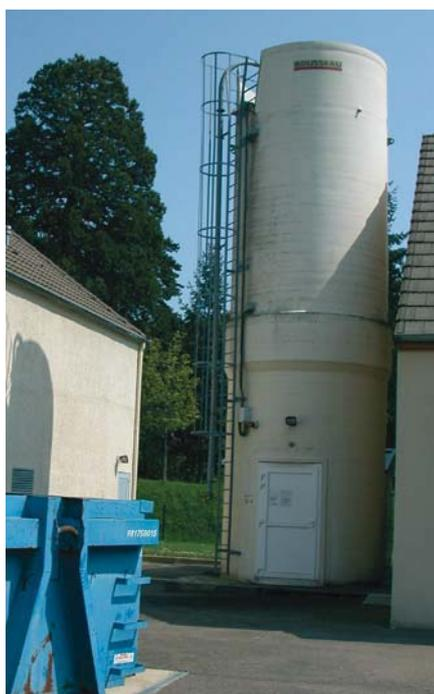
Le silo de charbon actif implanté entre le bâtiment de prétraitement et celui d'ultrafiltration.
