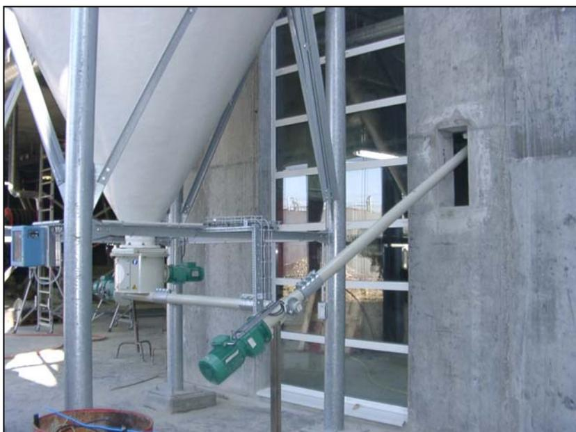
► Le dévoûteur-doseur permet de garantir un débit en aval quelle soit la configuration du circuit (doc. SODIMATE)
