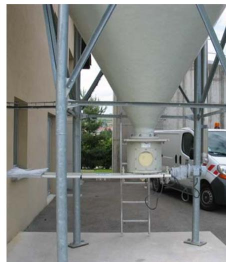
► **Cas d'application dans le traitement de l'eau pour doser la chaux / Application case in water treatment for lime feeding (doc. SODIMATE)**
