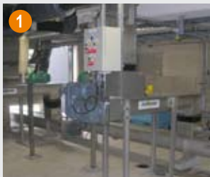
Mélangeur boue / chaux vive
